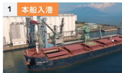
1 本船入港 配船会議、荷捌会議で決定した荷役スケジュールに従い本船が入港します。
