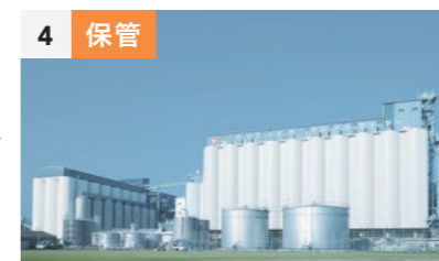
4 保管 搬入された穀物を、サイロで保管します。サイロには鋼板製とコンクリート製があります。
